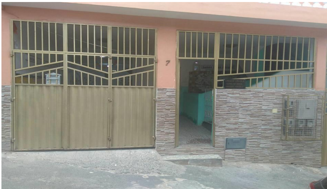
*FACHADA EXTERNA DA CRECHE ESCOLA COMUNITÁRIA MIGUEL FRÕES
