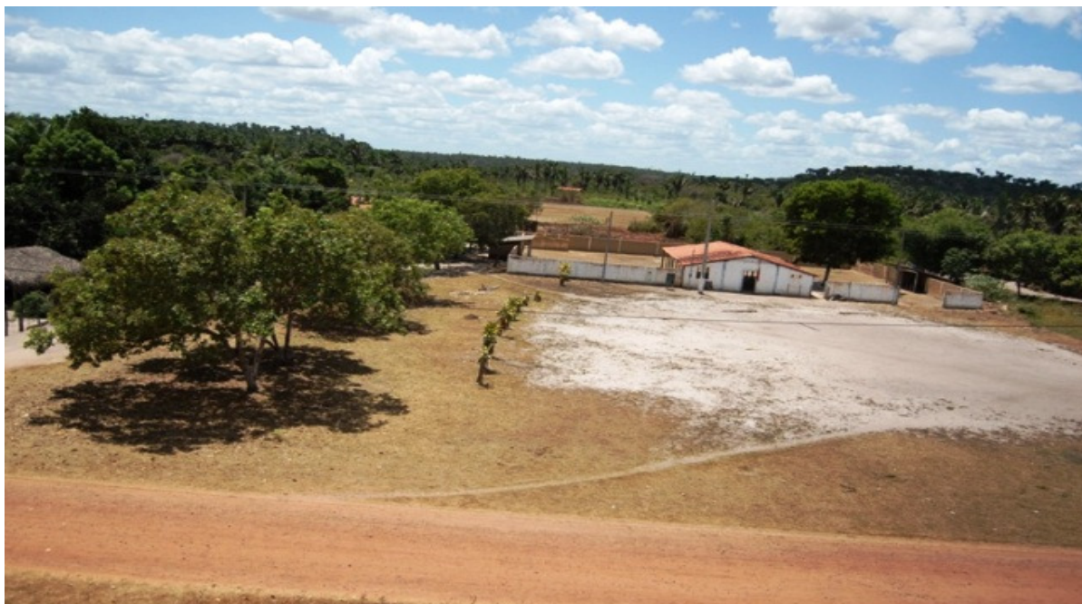
Figura 14 – Sede do Centro de Formação no assentamento Palmares
