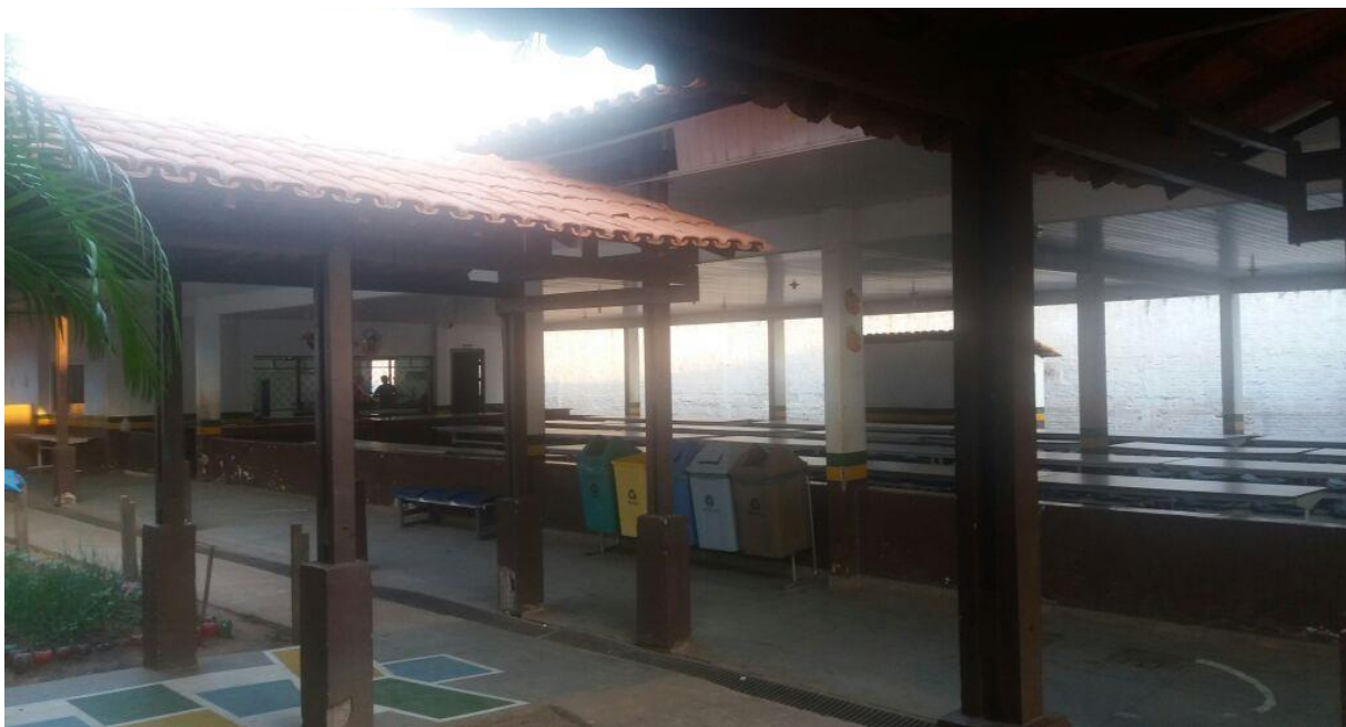
Figura 7 - acesso ao refeitório da escola Tancredo de Almeida Neves
