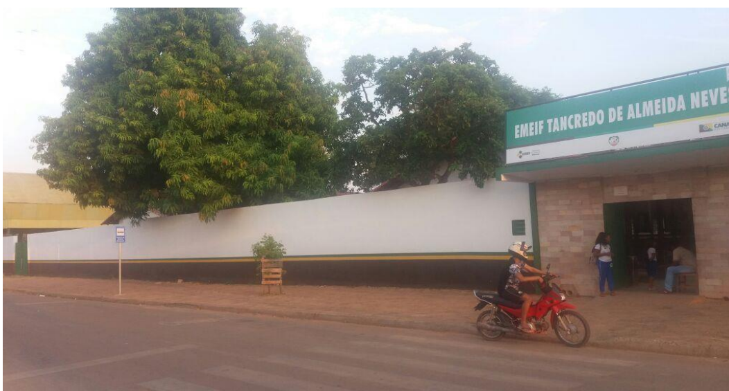
Figura 2 - Fachada da escola Tancredo de Almeida Neves
