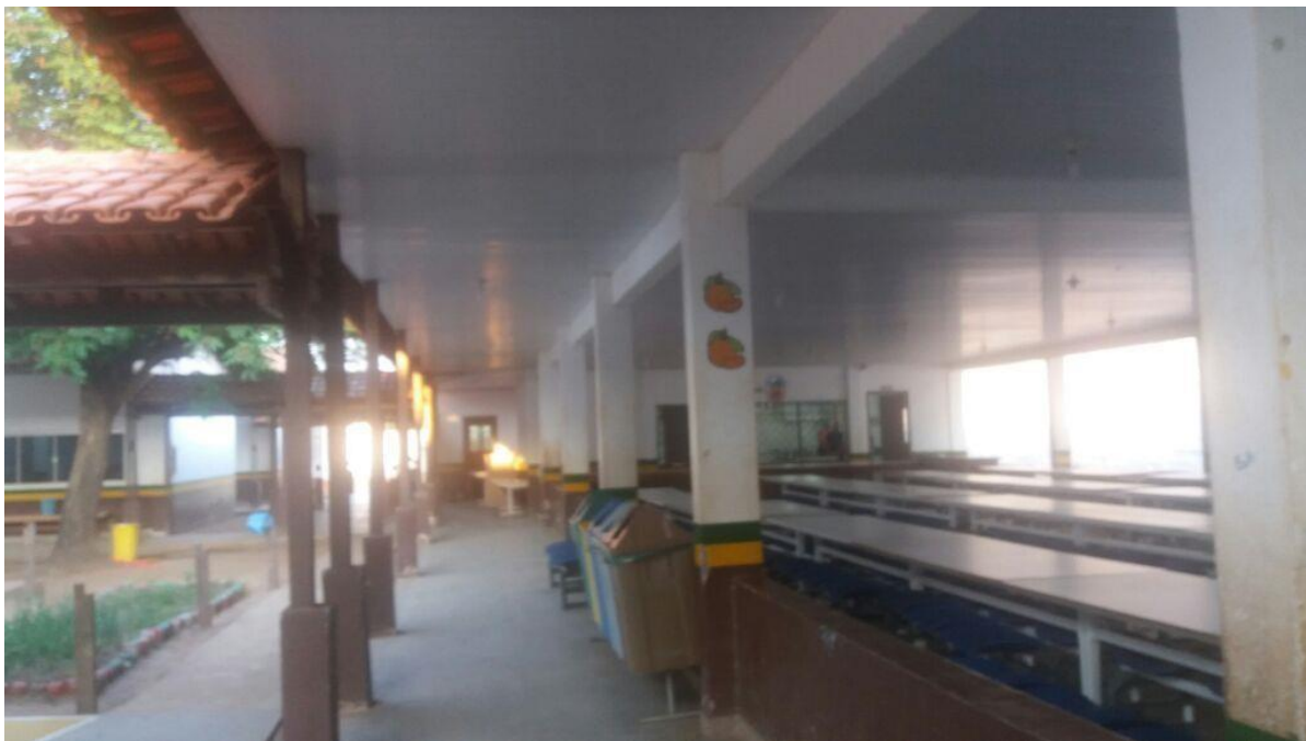
Figura 6 - acesso ao refeitório da escola Tancredo de Almeida Neves
